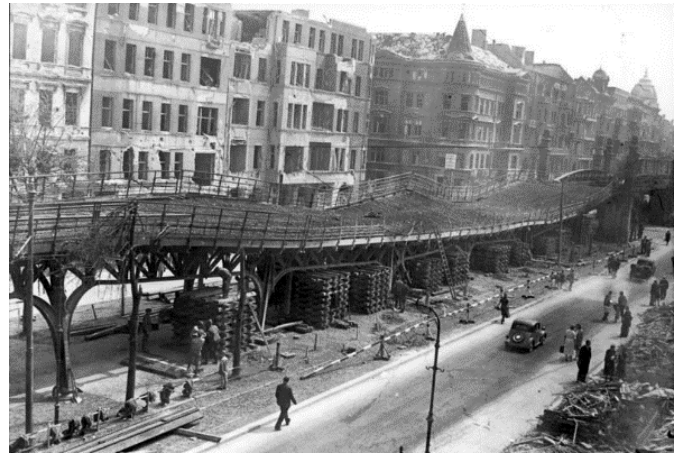
25.7.1944: Bombenschaden an der Hochbahnstrecke in Berlin-Schöneberg. Der Viadukt an der Bülowstraße erhielt am 19. Juli 1944 bei der Explosion einer Luftmine schwere Verwerfungen. Durch Holzstapel und Balken wird die Strecke provisorisch abgestützt.
